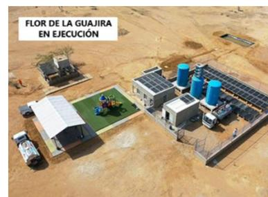
Construcción de obras en el punto de producción, sistema de ósmosis inversa, construcción pilas aferentes, suministro de dotación para pilas, componente social y aseguramiento en la comunidad de Flor de la Guajira, Uribia
