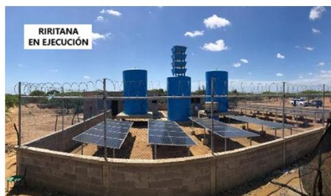
Construcción de obras en el punto de producción, sistema de tratamiento osmosis inversa, construcción pilas aferentes, suministro de dotación para pilas, componente social y aseguramiento en la comunidad de Riritana
