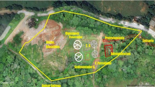
Predio de la PTAR, Colectores y Descole
