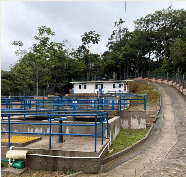
Foto: PTAR Mocoa
