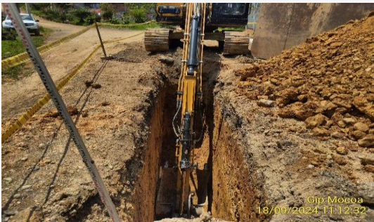
Ejecución 10km de Colectores e Inicio obras de la PTAR
