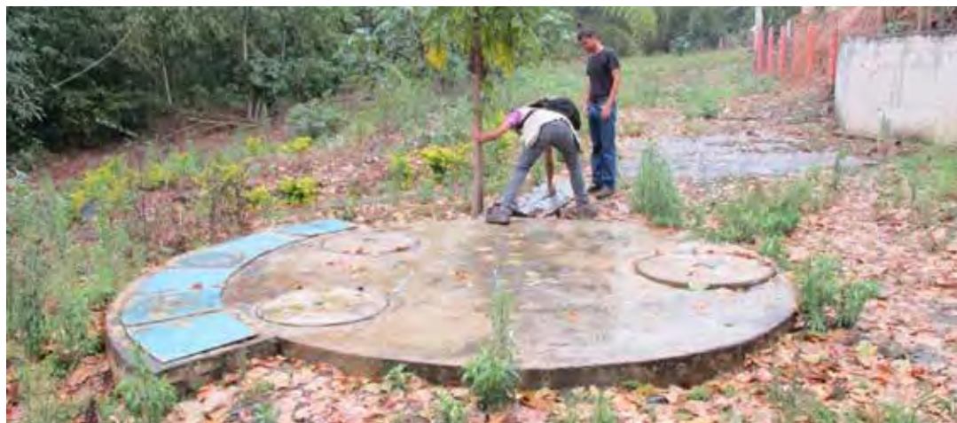
Inspección sanitaria de un sistema de tratamiento de aguas residuales
