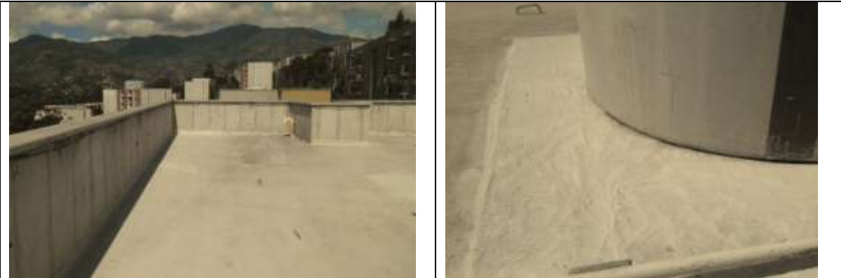
Obras de Impermeabilización que se han adelantado 16/09/2016
