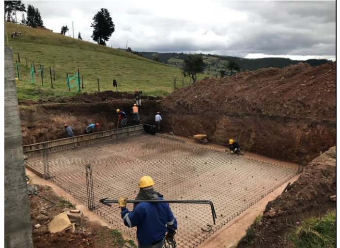
Construcción Tanque de Almacenamiento
