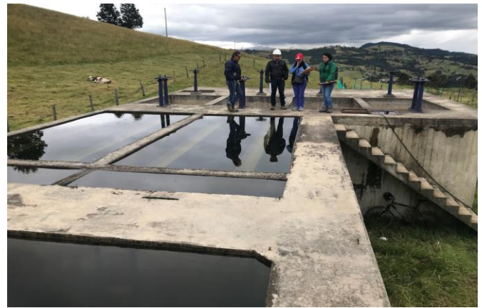
Sedimentador de Alta Tasa
