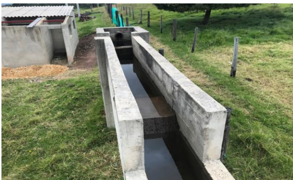
Vertedero y Floclador PTAP Santa Rosa de Viterbo
