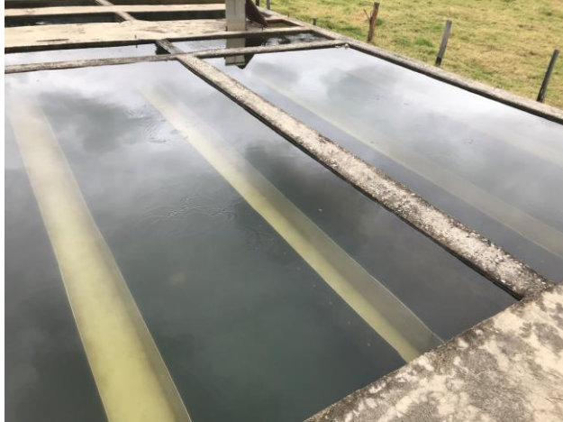
Sedimentador de Alta Tasa
