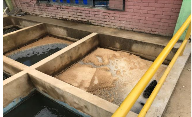
Floculador Tipo Alabama En funcionamiento.
