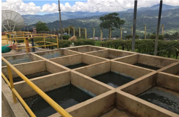
Floculador Tipo Alabama En funcionamiento.
