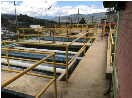
Sedimentador en funcionamiento
