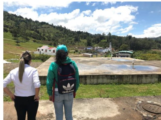
Filtros y Tanque de Almacenamiento de 500 m 3 en Funcionamiento
