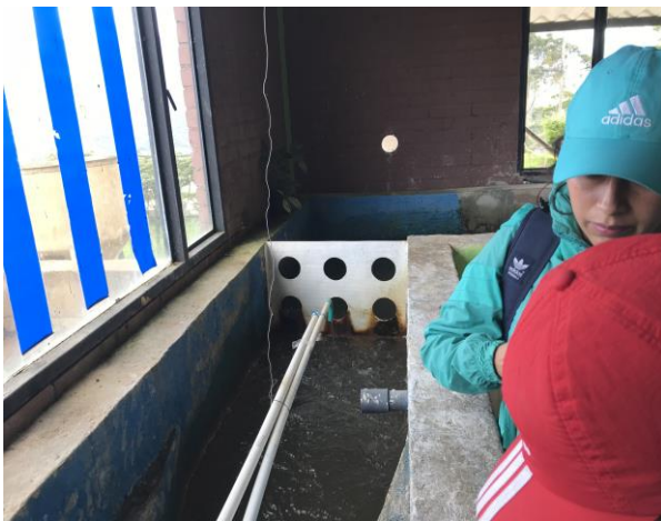
Canaleta Parshall en funcionamiento
