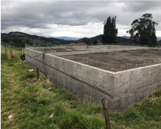
Construcción Tanque de Almacenamiento
