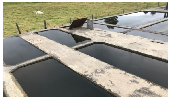
Vertedero y Floclador PTAP Santa Rosa de Viterbo
