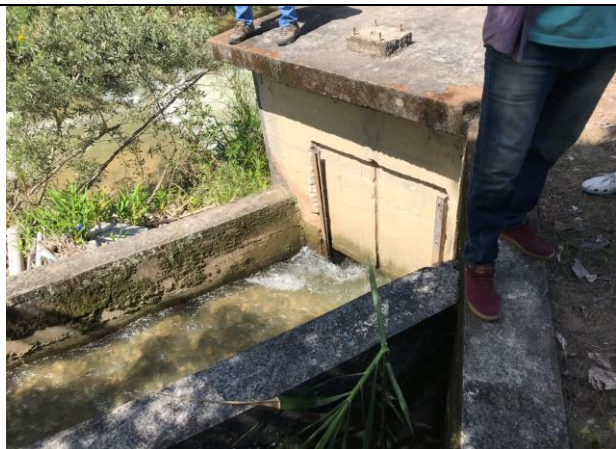
CANALETA PARSHALL Y FLOCULADOR PTAP EXISTENTE. MUNICIPIO DE ROVIRA, TOLIMA
