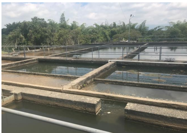
VISTA FLOCULADOR, SEDIMENTADOR Y FILTROS PTAP. MUNICIPIO DE MONTENEGRO, QUINDÍO.
