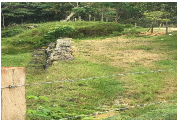
GAVIONES DE PROTECCION Y REPTACION DEL SUELO ALEDAÑO AL TANQUE DE ALMACENAMIENTO. MUNICIPIO DE VILLARRICA, TOLIMA.
