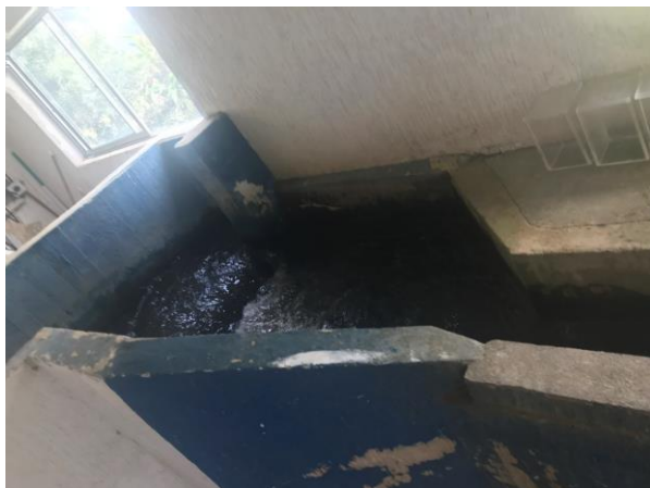
Vista de Vertedero para Mezcla Rapida. Municipio de Montenegro, Quindío.
