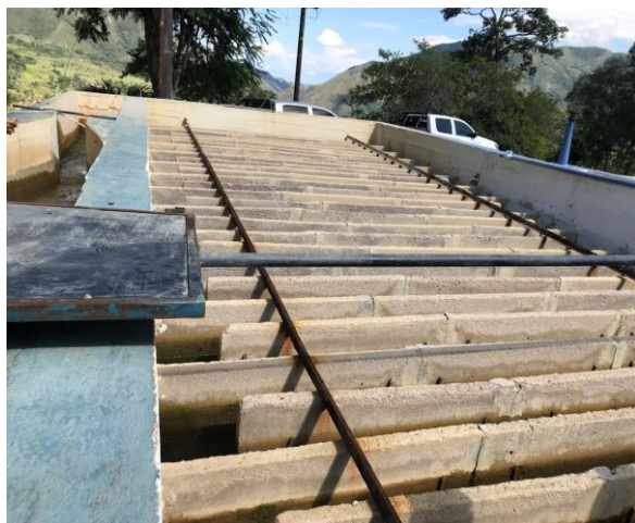
CANALETA PARSHALL Y FLOCULADOR PTAP EXISTENTE. MUNICIPIO DE ROVIRA, TOLIMA
