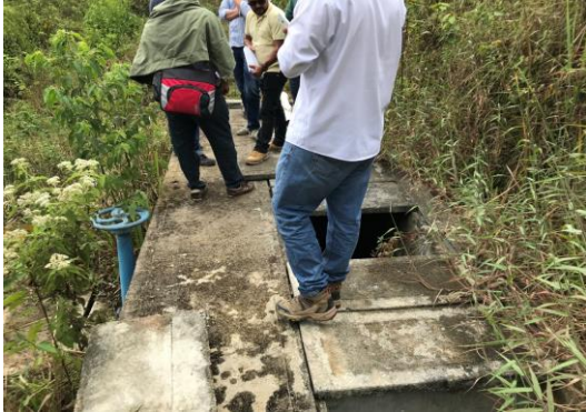
DESARENADOR ABANDONADO. MUNICIPIO DE VILLARICA, TOLIMA
