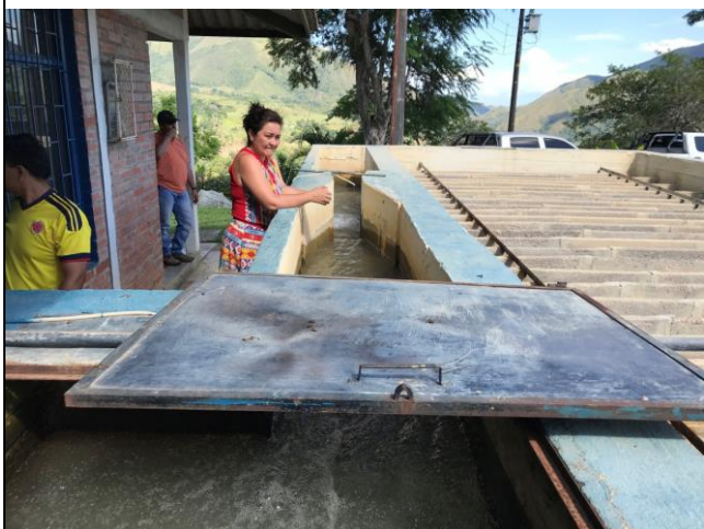
CANALETA PARSHALL Y FLOCULADOR PTAP EXISTENTE. MUNICIPIO DE ROVIRA, TOLIMA
