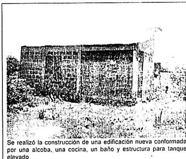
La edificación se realizó en mampostería confinada conservando lo básico para viviendas de un piso NSR-98, aplicable para la época de construcción.
