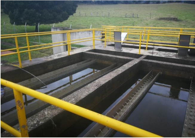
FILTRACION Y SEDIMENTACION PTAP TERMINADA, SANTA ROSA DE VITERBO BOYACÁ.
