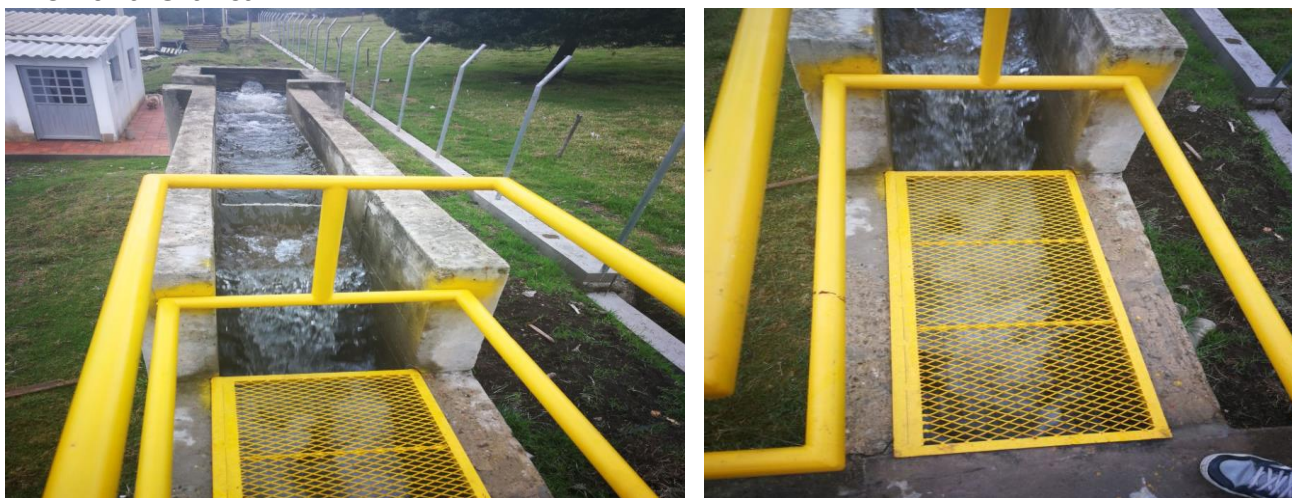
ENTRADA Y MEZCLA RAPIDA PTAP TERMINADA, SANTA ROSA DE VITERBO BOYACÁ.
