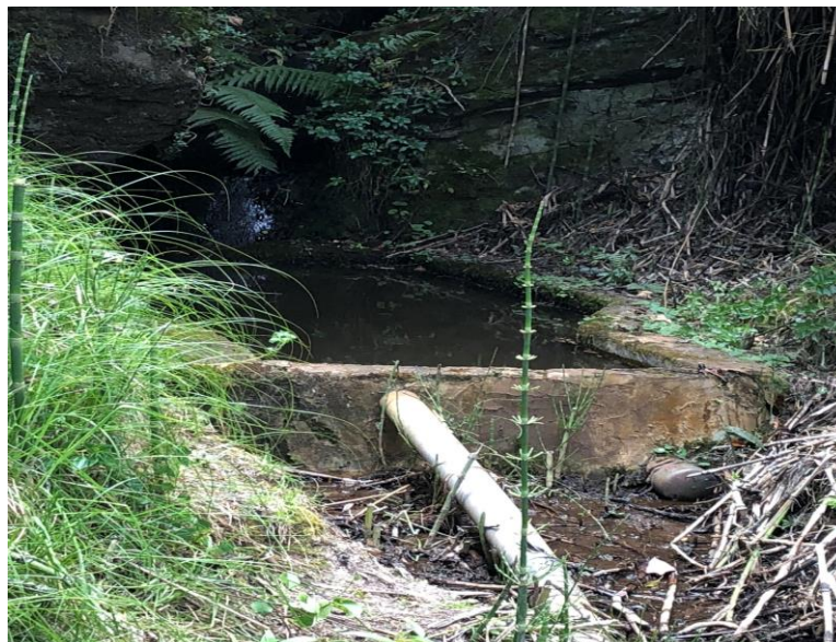
CAPTACION DE AGUA ARTESANAL DONDE QUEDARA UNA GALERIA FILTRANTE PROYECTADA, MUNICIPIO DE CUCAITA-BOYACÁ
