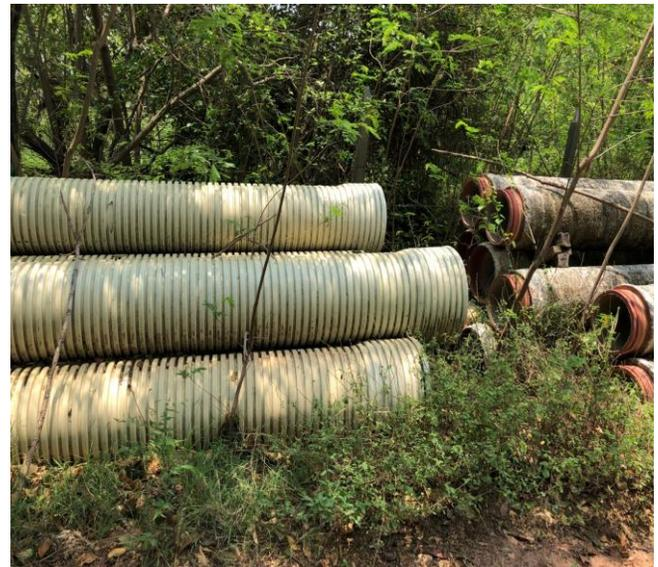
Tuberías en Concreto y PVC, a la intemperie y mal almacenadas – Girardot, Cundinamarca, 20 de marzo de 2018.
