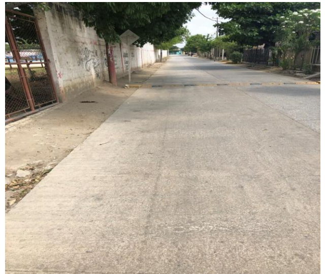
Tubería enterrada e instalada del proyecto - Corozal, Sucre, 16 de marzo de 2018.
