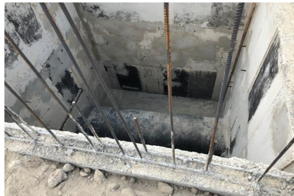
Empalme y Construcción de caja de Macromedidor Proyecto – Corozal, Sucre, 16 de marzo de 2018.
