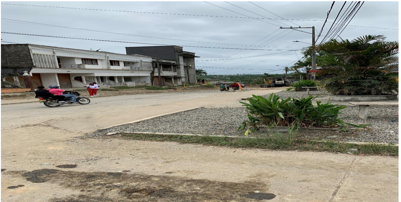
Figura 3. Acueducto de izquierda a derecha y arriba a abajo: 1) Vía adyacente del circuito 18 con su respectiva válvula de cierre. 2) reunión con la interventoría de obra Secretario de Planeación y representantes del MVCT. 3) pavimentación de la vía circuito 19, Municipio de Quibdó, 27 de marzo de 2019
