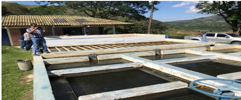
Sedimentador existente. Municipio de Rovira (Tolima)
