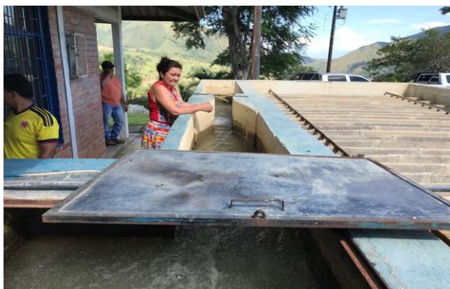
Canaleta parshall y floculador PTAP existente. Municipio de Rovira (Tolima)
