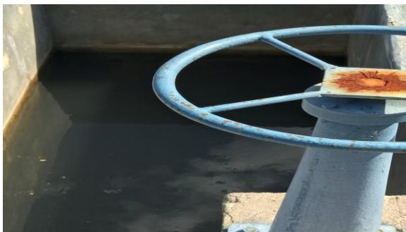
Sedimentador existente. Municipio de Rovira (Tolima)
