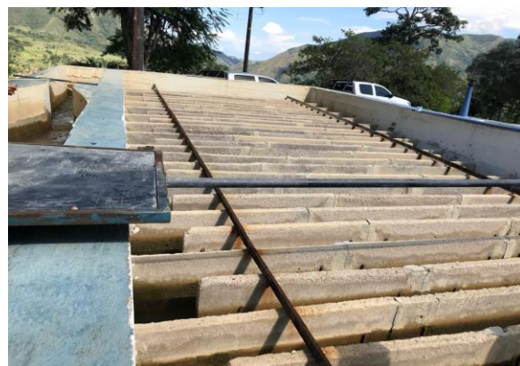
Canaleta parshall y floculador PTAP existente. Municipio de Rovira (Tolima)
