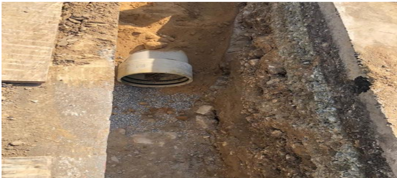
Tubería Instalada Tramo k4 + 355 hasta el K 6 + 280
