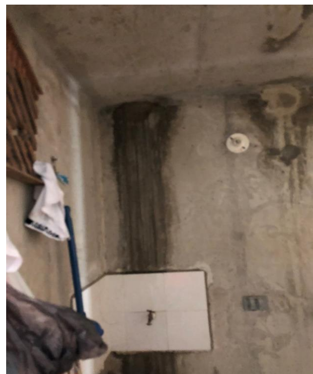
TANQUE DE ALMACENAMIENTO DE AGUA NO PERMITIDOS Y HUMEDADES EN APARTAMENTOS TORRE A, URBANIZACIÓN CIUDEDELA REAL DEL CARIBE, ETAPA II, MALAMBO – ATLANTICO.
