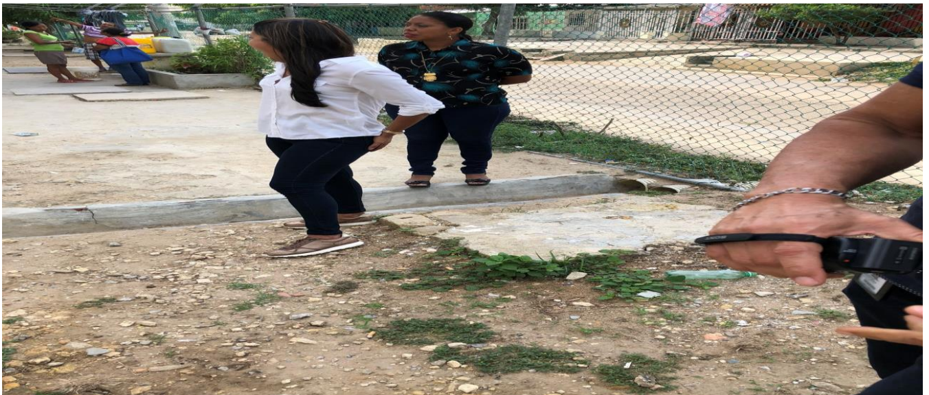
CANALES Y BAJANTE DE AGUAS LLUVIAS, URBANIZACIÓN CIUDELA REAL DEL CARIBE, ETAPA II, MALAMBO – ATLANTICO.
