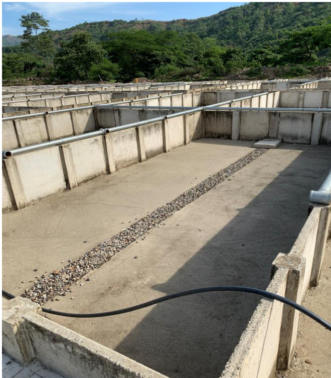
Figura 5. Lechos de Secado; Municipio de Yopal, 29 de abril de 2019
