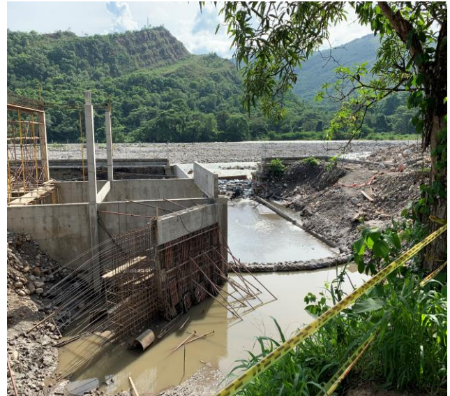
Figura 1. Bocatoma Lateral, Municipio de Yopal, 29 de abril de 2019
