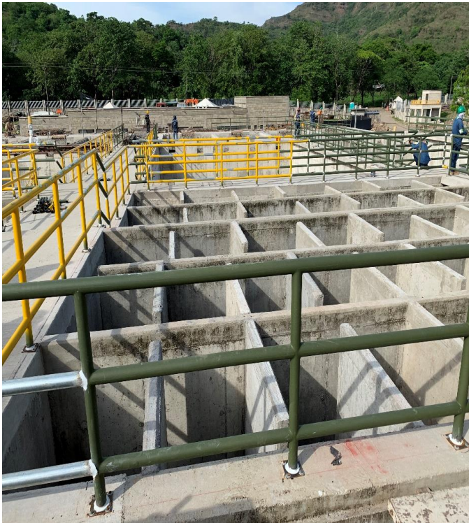
Figura 6. Canaleta Marshall y floculador PTAP; Municipio de Yopal, 29 de abril de 2019
