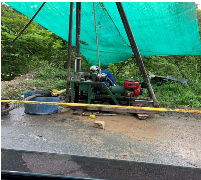
Figura 8. Estudio geotécnico K2 + 090 sector Puente la Cabuya; Municipio de Yopal, 29 de abril de
