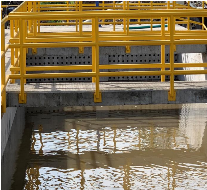
Figura 3. Desarenador; Municipio de Yopal, 2019
