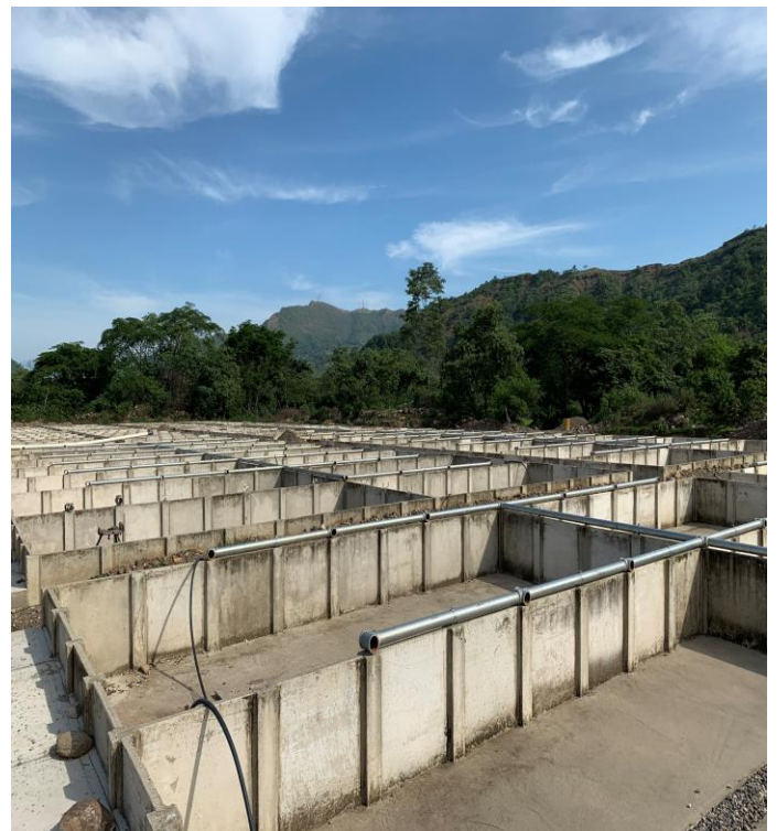
Figura 5. Lechos de Secado; Municipio de Yopal, 29 de abril de 2019
