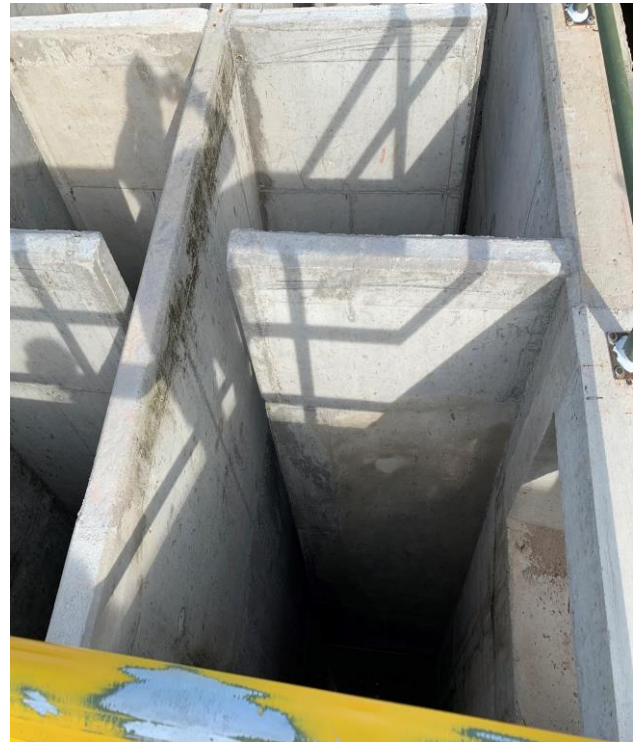
Figura 6. Canaleta Marshall y floculador PTAP; Municipio de Yopal, 29 de abril de 2019
