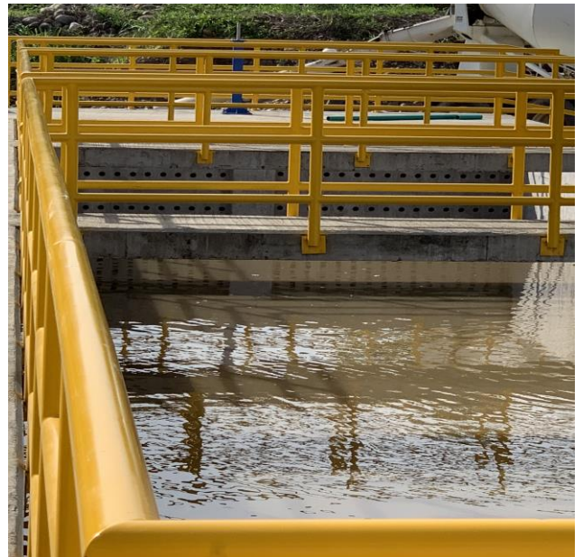
Figura 3. Desarenador; Municipio de Yopal, 2019
