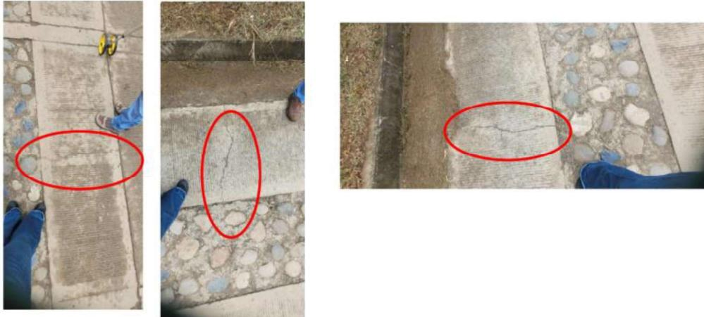
5. En el recorrido se identificaron losas de placas de concreto deterioradas desde el K0+733 a K0+888 del lado izquierdo de la vía.
