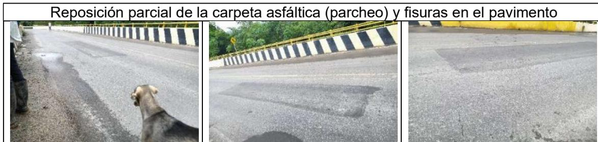
Así mismo se observó, que las Barandas en concreto Tipo New Jersey, presentan múltiples fisuras, y que las barandas metálicas no están protegidas con pintura anticorrosiva, y el óxido ha empezado a deteriorarlas.
