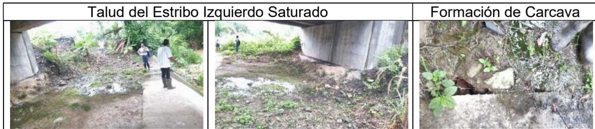
De la visita realizada por la CGR se concluye que la obra presenta deterioro prematuro por deficiencias en los sistemas de drenaje, fisuras en los muros de confinamiento de la estructura del pavimento, falta de mantenimiento de las cunetas y por la formación de cárcavas en el talud del estribo izquierdo.
