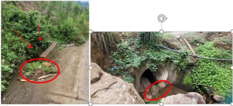
4. En la inspección visual se detectaron fisuras en losas de placas de concreto de la placa huella construida, desde K0+485 a K0+750, como consecuencia de la falta de mantenimiento consistente en el retiro de elementos que puedan afectar el tránsito vehicular, como basura, piedras, sedimentos, vegetación o derrumbes; encausar escorrentías para evitar que socaven la tierra en los bordes de la losa; así como revisar agrietamientos o fisuras de la losa.
