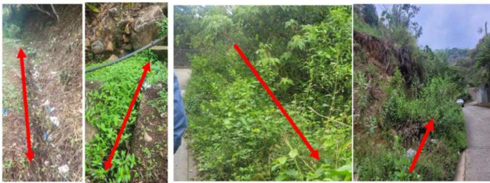
2. En el recorrido se evidenció obstrucción del canal en concreto, por construcciones posteriores al lado derecho de la vía, impidiendo el flujo adecuado del agua, como consecuencia de la falta de mantenimiento vial no ejecutado que consiste en retirar
