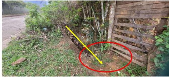
3. En la revisión de alcantarillas y estructuras de drenaje construidas o mejoradas, se detectó falta de mantenimiento consistente en el retiro manual de todo tipo de material extraño, depositado, sedimentado y/o vegetación que no permite el paso del agua a través de la alcantarilla; además se debe realizar la limpieza de la entrada (encole) y salida (descole) del agua a la alcantarilla.
