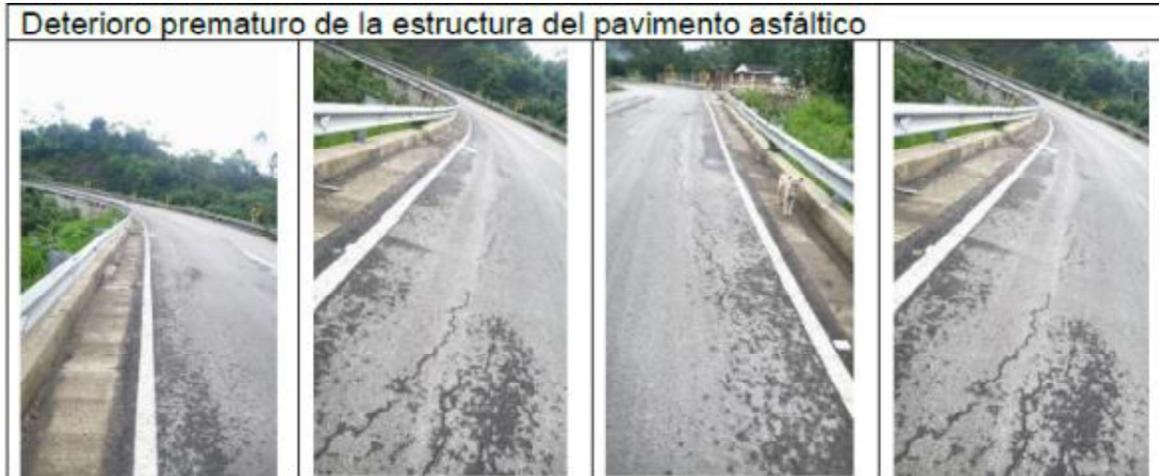
Según lo anterior, se presenta deterioro prematuro en la carpeta asfáltica, el cual se manifiesta -para este caso-, inicialmente mediante fisuras que se convierten en grietas. Si estas no se corrigen, pueden generar a futuro afectación por el hundimiento de calzada, desplazamiento de berma, y medias lunas, que terminan afectando la movilidad de la vía.
