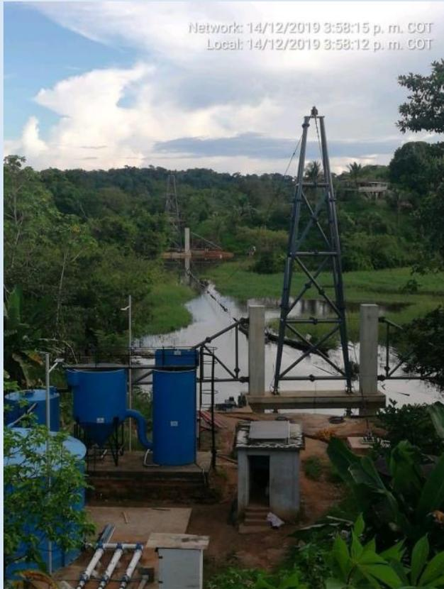
Planta de agua potable incluye planta de soporte, accesorios de HD y componentes en fibra de vidrio según Diseño para un caudal de 20.7 l/s. Caseta de operación y sistema Eléctrico
