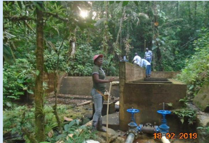
Adecuación línea de conducción incluye (excavaciones, rellenos, cajas, accesorios, adecuación y construcciones de viaductos, adecuación de tuberías, instalación de válvulas de corte, purga y ventosas
