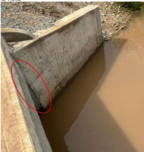
Fisuración entre aleta y cabezote de la estructura de Box Culvert.
