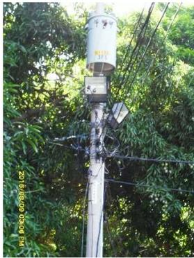
a. Identificación de puntos de pérdida energética v.g conexiones fraudulentas y conexiones poco prolijas
