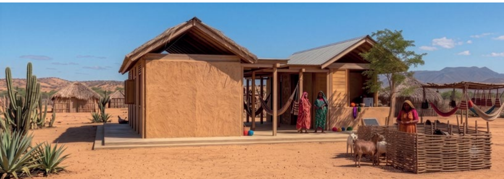
Figura 13. Vivienda para la comunidad wayuu en la Guajira. Sistema de vivienda rural. Arq. SMG.
