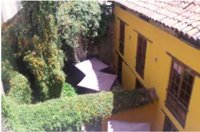
Registro Fotográfico No 7
