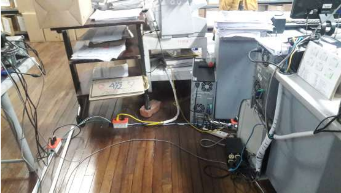
Registro Fotográfico No 17
