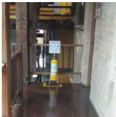
Registro Fotográfico No 3
