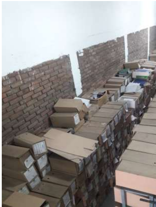
Registro Fotográfico No 19
