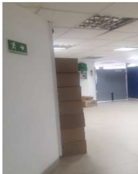
Registro Fotográfico No 16
