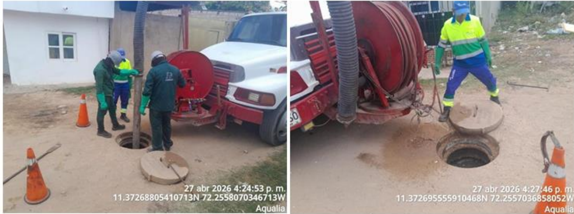
Ilustración 7 Actividades de limpieza con camión succión-presión a manhole correspondiente
