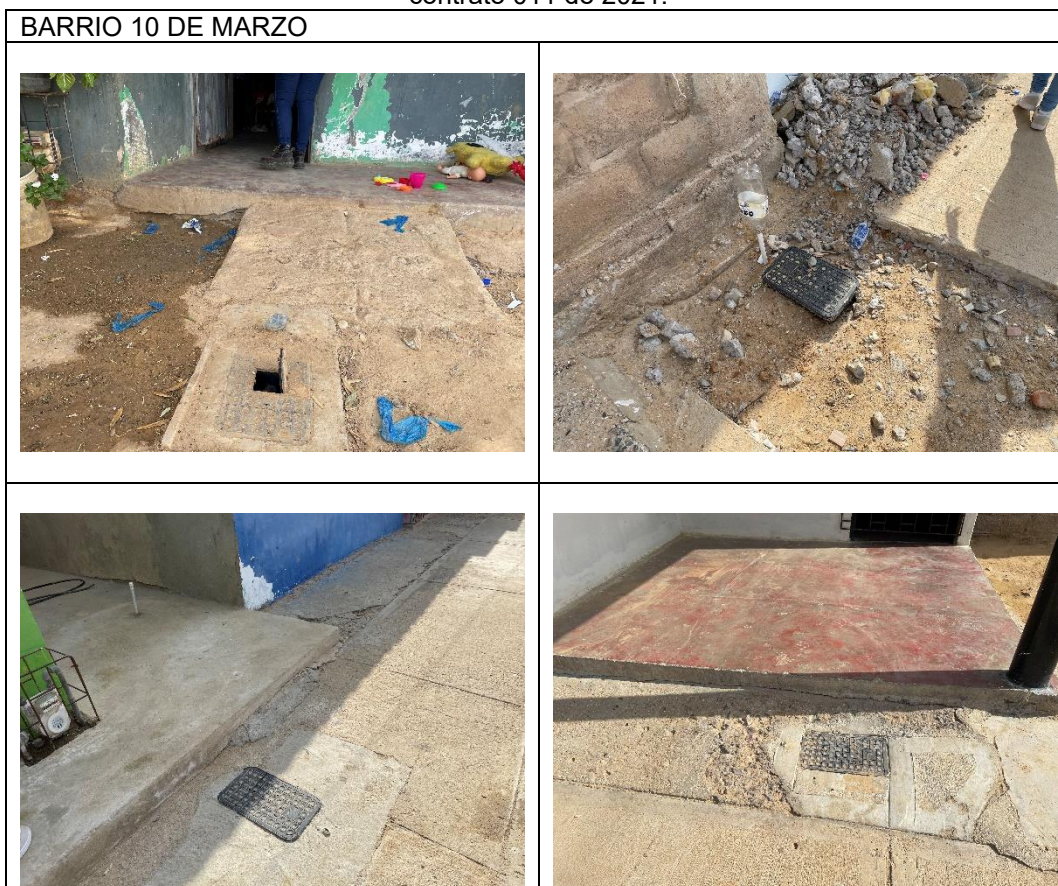
Imagen 8. Registro fotográfico de los micromedidores instalados en el barrio 10 de marzo del contrato 011 de 2021.
