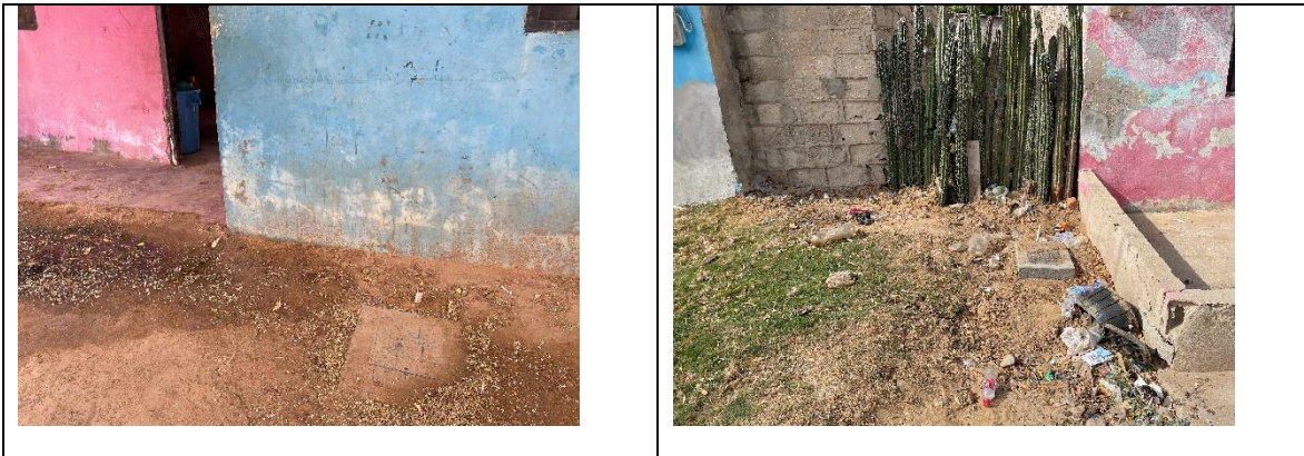
Fuente: Registro fotográfico tomado por la CGR durante la visita los días comprendidos del 13 al 15 de abril en el marco del contrato de obra 011 de 2021.
