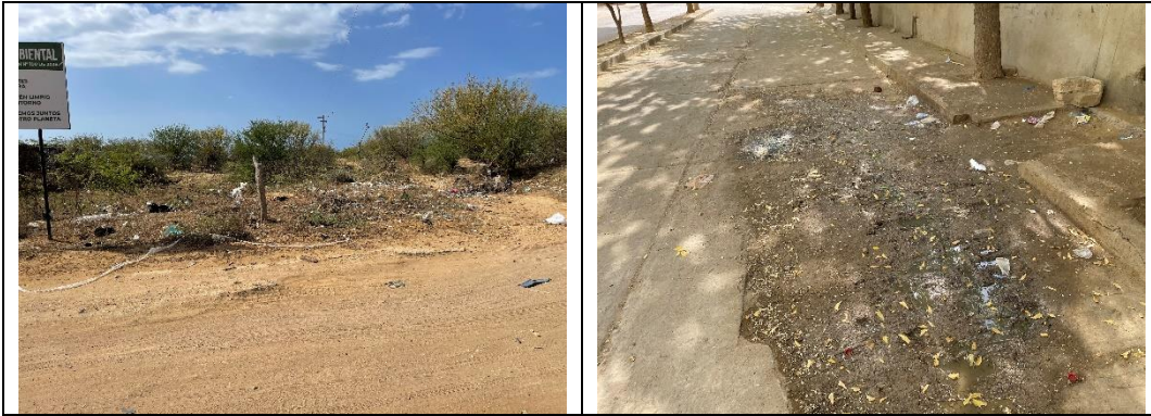
Fuente: Registro fotográfico tomado por la CGR durante la visita los días comprendidos del 13 al 15 de abril en el marco del contrato de obra 011 de 2021.
