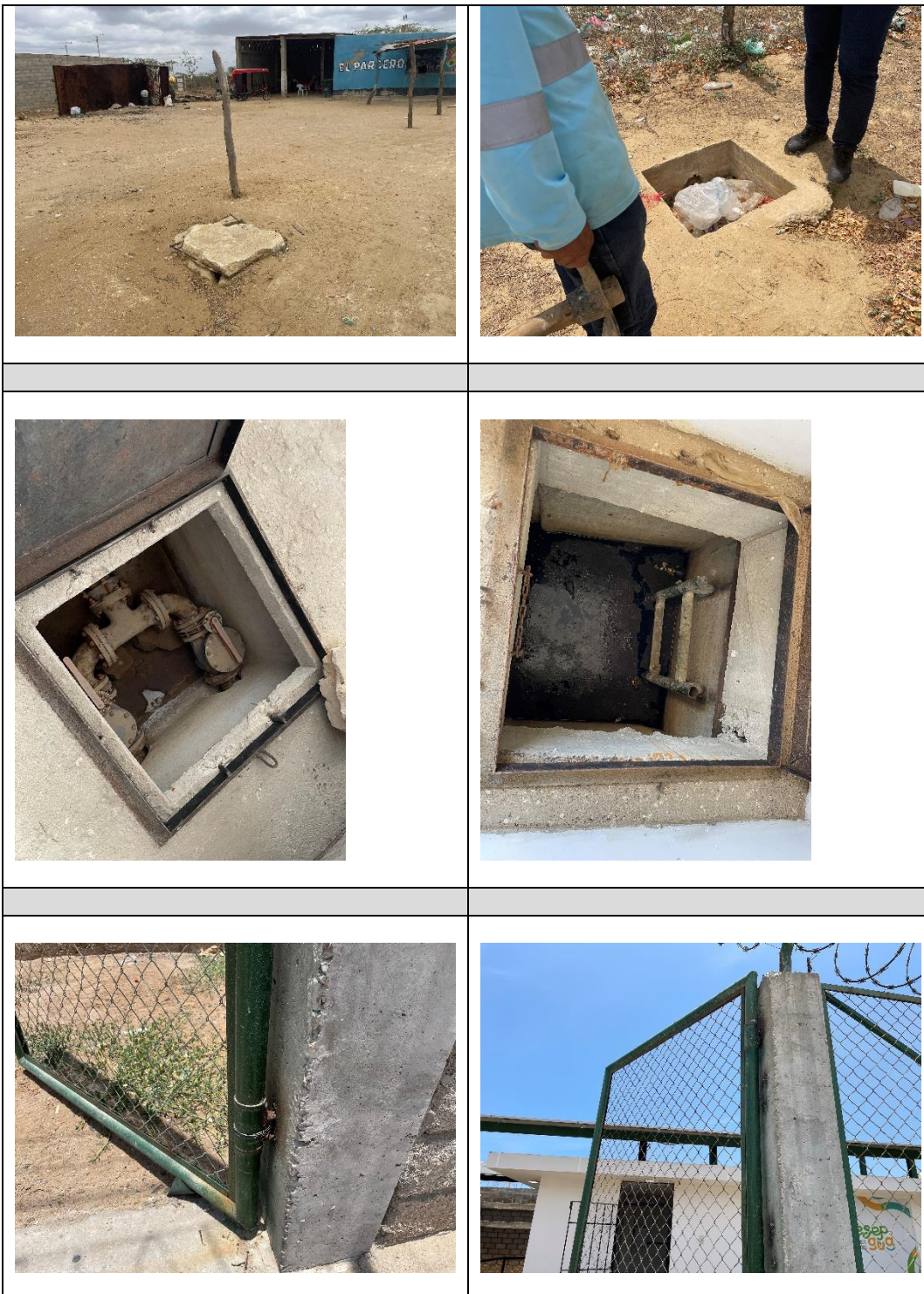
Fuente: Registro fotográfico tomado por el equipo auditor durante la visita. 2026
