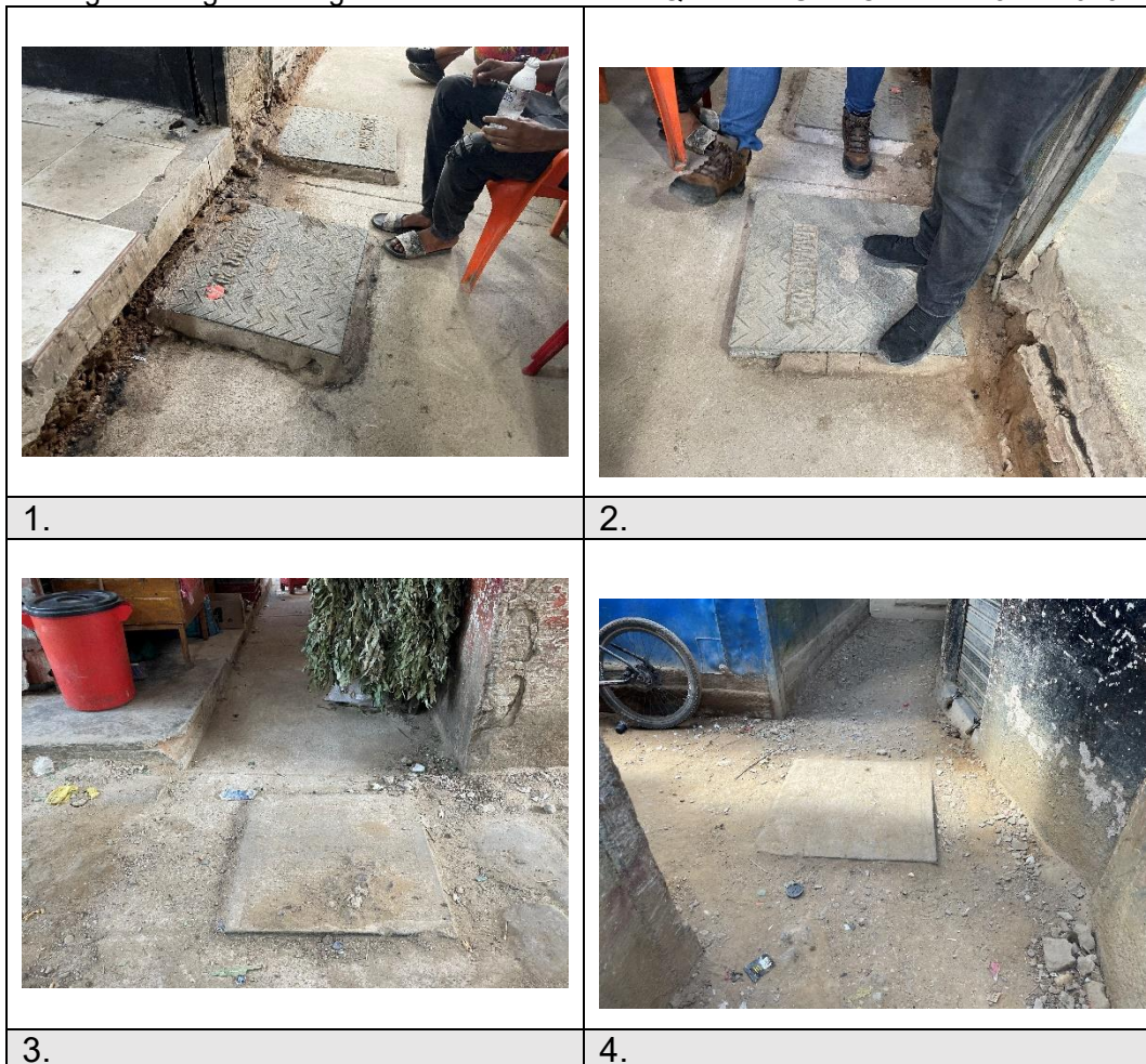
Imagen 2 Registro fotográfico contrato de obra AQPENINSULA-OBRA- A25A1DI049.
