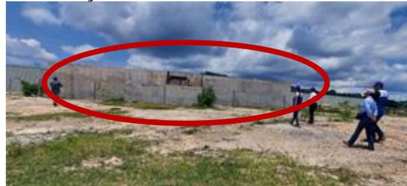
Vista lateral del tanque de almacenamiento de 3000 metros cúbicos construido en concreto reforzado de 4000 PSI en inmediación de la Estación de Servicio San Pablo, en jurisdicción de Lebrija.
