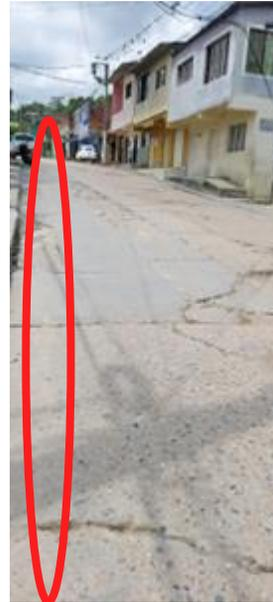
Tubería de hierro dúctil de 10" instalada al costado de la acera con reposición de pavimento, en la vía que conduce de la planta de tratamiento a la estación de servicio San Pablo, en jurisdicción de Lebrija.
