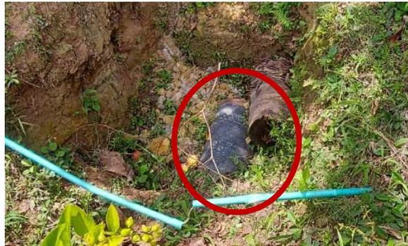
Tubería de hierro dúctil de 10" que ingresa al tanque de distribución de la Planta de Tratamiento de Agua Potable de Lebrija
