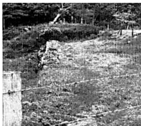
GAVIONES DE PROTECCION Y REPTACION DEL SUELO ALEDAÑO AL TANQUE DE ALMACENAMIENTO. MUNICIPIO DE VILLARRICA, TOLIMA.
