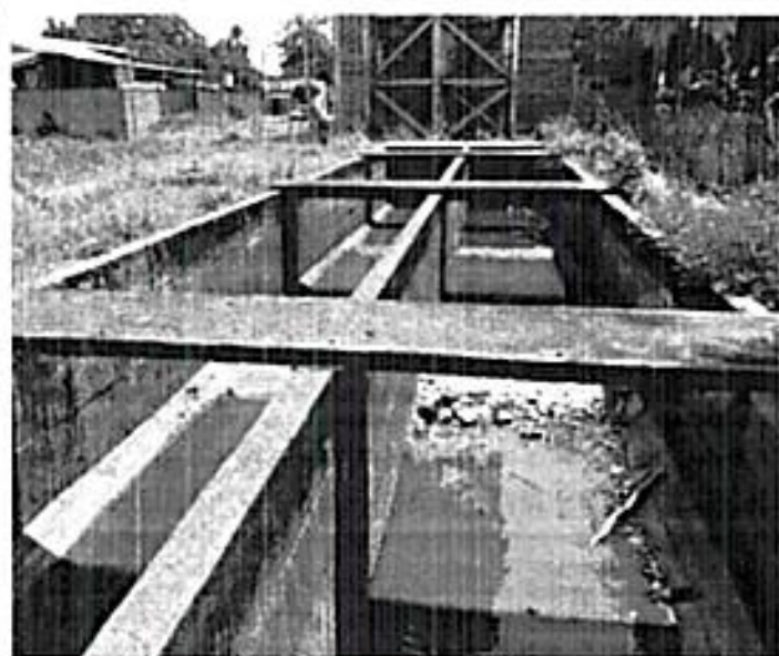
Desarenador para optimizar, en estado de abandono, Municipio de Saldaña- Tolima.
