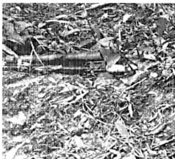
ADUCCION TUBERIA DESEMPATADA Y CON FUGAS. MUNICIPIO DE VILLARICA, TOLIMA.
