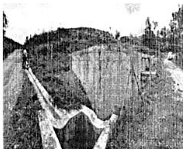
GAVIONES DE PROTECCION Y REPTACION DEL SUELO ALEDAÑO AL TANQUE DE ALMACENAMIENTO. MUNICIPIO DE VILLARRICA, TOLIMA.
