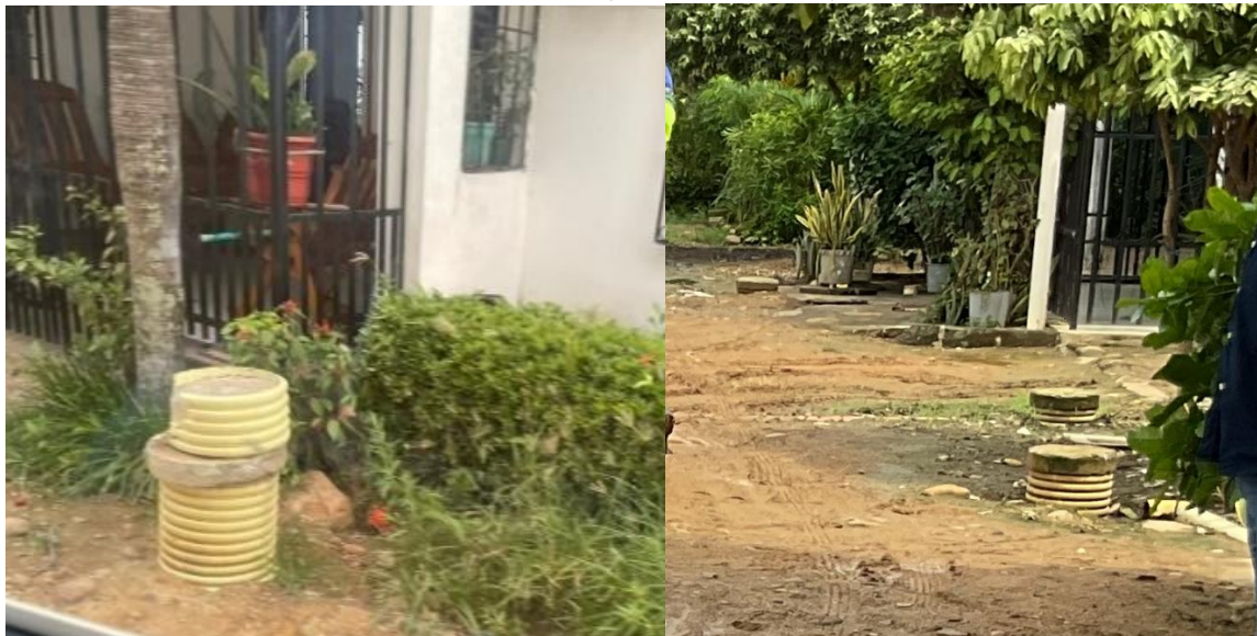
Ilustración No. 7: Estado actual y acabado de las cajas domiciliarias.
